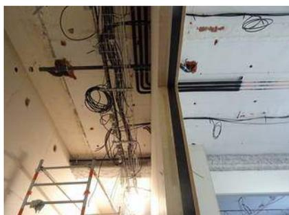
Cependant, il a fallu mettre des alarmes incendie partout, Toute l'électricité a été refaite aussi. On en a profité pour rénover les canalisations de gaz, d'eau chaude et froide, d'électricité, et bien les séparer. Que de tuyaux presque bouchés par le tartre... au bout de quelque 70 ans pour certains, c'était permis ! Et par ci par là, on a découvert quelques fils électriques encore sous coton !
